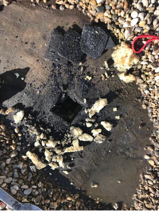
Carottage sur le toit du 26 : un filet d'eau permanent coule sous isolation
